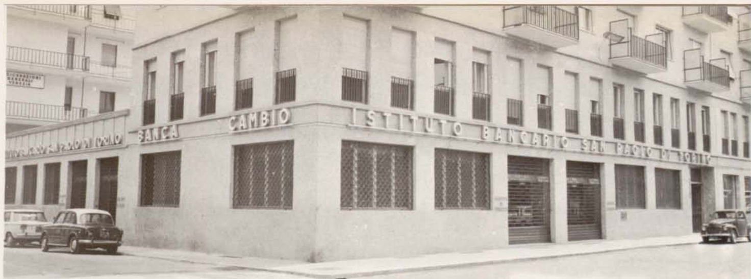
La facciata esterna
